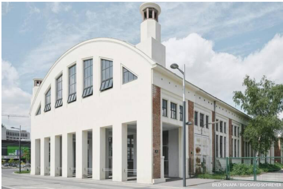
Die 'Ballonhalle' im Wiener Arsenal
