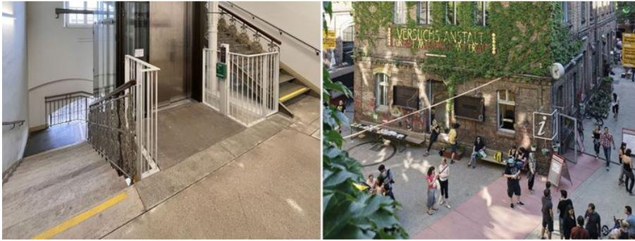
Linkes Bild: Für den Lifteinbau wurde ein Teil der Treppe versetzt.
