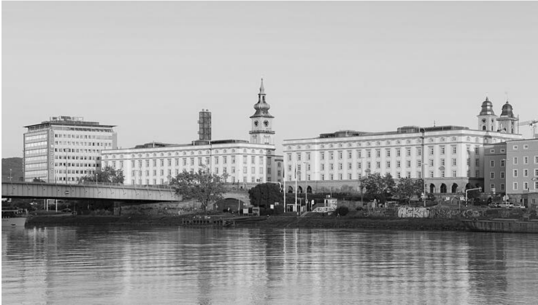
Die Brückenkopfgebäude nach vier Jahren Bauzeit
