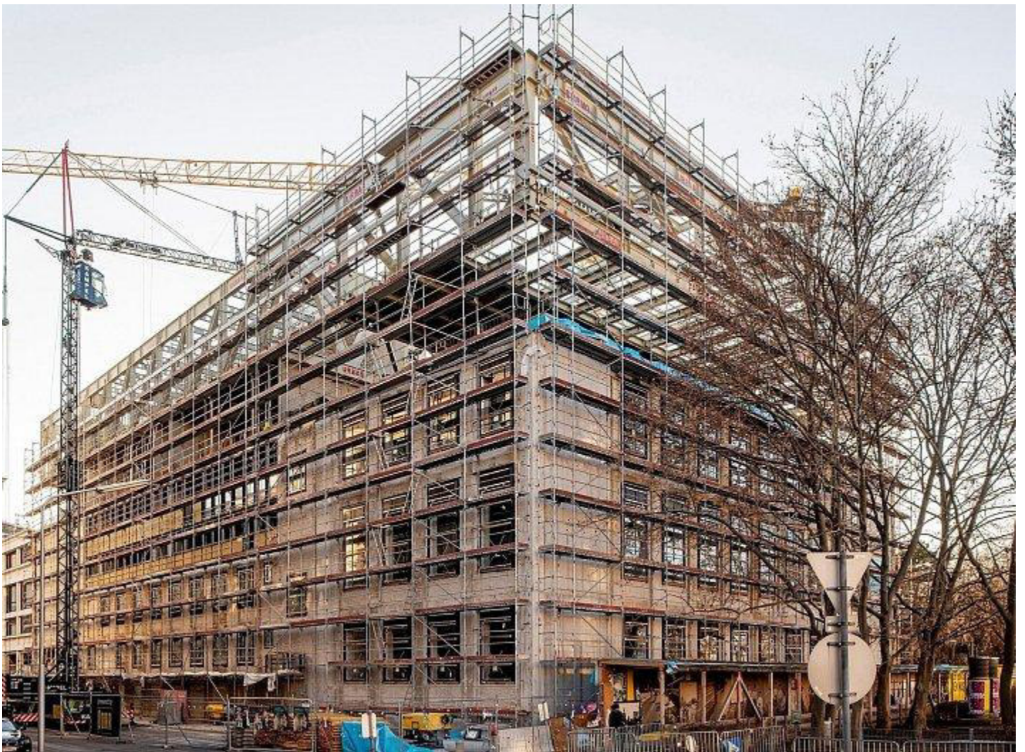
Das Wien Museum wächst: Die Stahlkonstruktion für die neuen Ausstellungsflächen ist am Dach fixiert. - © Kollektiv Fischka / Kramar
