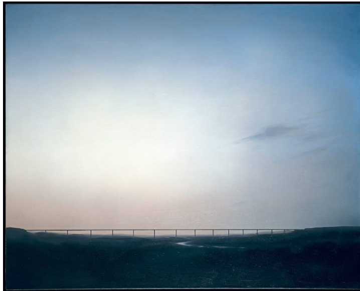
Vermeintliche Idylle: Der ideale Ausblick wird von der brutalen Ruhrtalbrücke gestört.
