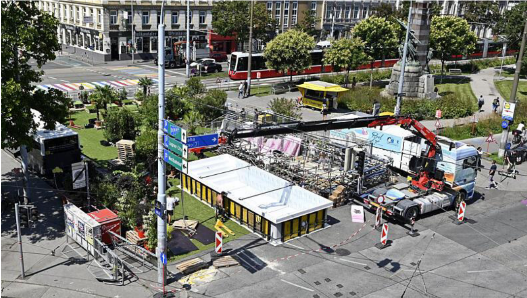
Aufbauarbeiten zur Aktion "Gürtelfrische West"
