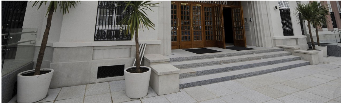
2009 wurde das Gebäude saniert
