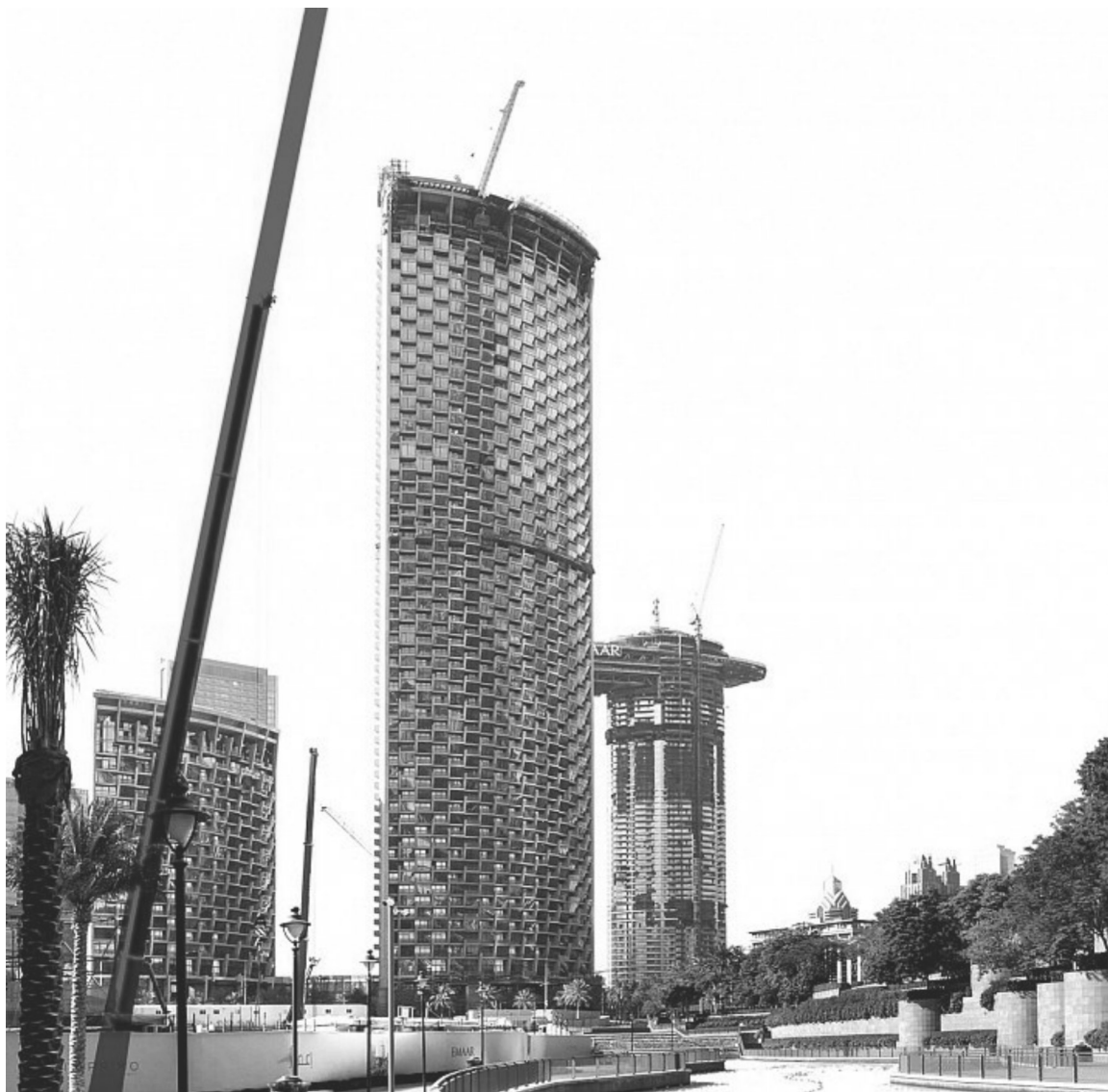
Bauen bis in den Himmel über Dubai: Peter Hoiß bringt einen Kran zum Erröten. - © Peter Hoiß
